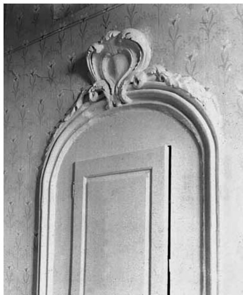
10.att. Aizmūrētā aila no hercogienes apartamentu priekštelpas uz pils kapelu. 20.gs. sāk. foto
